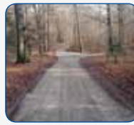
Remont drogi „Poręba” w Sączowie
