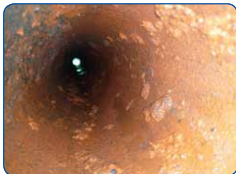
Skorodowana rura stalowa
