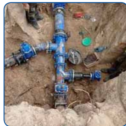
Wymiana kawałka rurociągu stalowego na PE w Przegini
