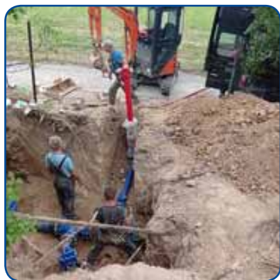
Wymiana układu zasuw w Przegini
