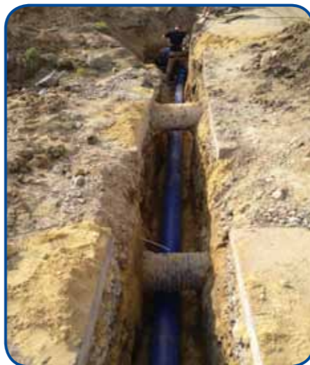
Wymiana kawałka rurociągu stalowego na PE w Przegini
